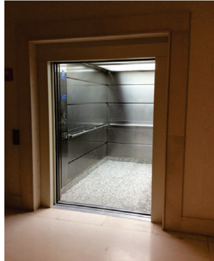
Fig. 2. Ascensor de acceso a las plantas del museo. Fuente: Elaboración propia.
