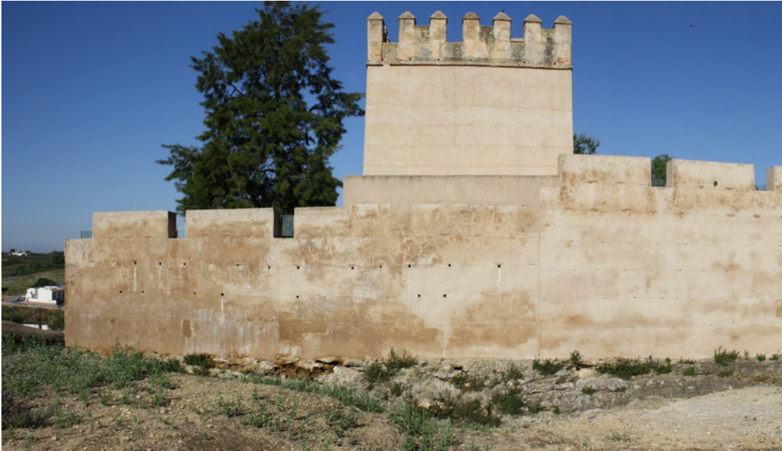
Fig. 5. Vista panorámica de la entrada del Castillo restaurada ( s.XVI). Se distinguen por medio de distintos color la entrada situada en el cuerpo de guardia, las troneras de artillería y las distintas fases constructivas del lienzo de muralla. Foto: A. Gómez. Archivo Casa-Museo Bonsor.Castillo de Mairena.
