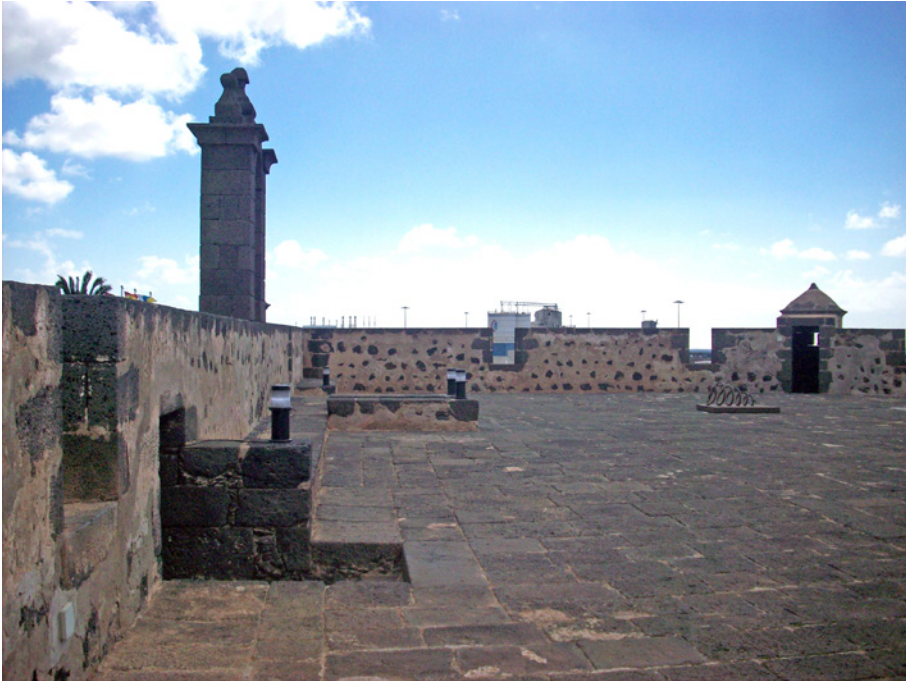
Fig. 6. Cubierta mirador del Castillo.
