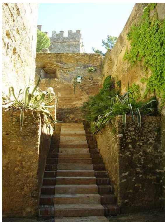
Fig 2. Aspecto final de la restauración de la escalera de entrada desde la Vega. Foto: A. Gómez
