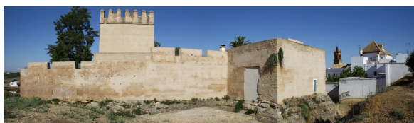
Fig. 3. Vista panorámica de la entrada del Castillo del s.XVI restaurada. Se distinguen en distinto color la entrada situada en el cuerpo de guardia y la tronera de artillería y las distintas fases constructivas del lienzo de muralla. Foto: A.Gómez)
